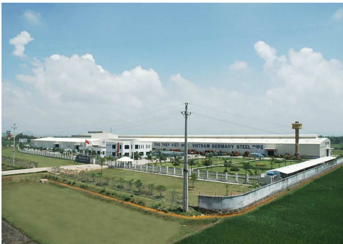
Toàn cảnh Nhà máy ống thép Việt Đức
